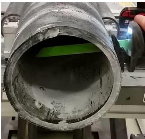
Kapning med tigersåg och diamantbelagt blad.
